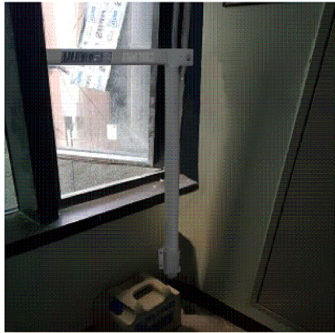
현장 설치 예
