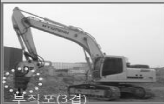
브레이커3걸 방음덮개 설치
