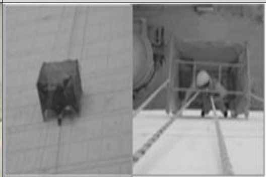
도장작업 시 방진막 설치
