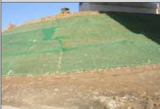
성토부 방진덮개 설치
