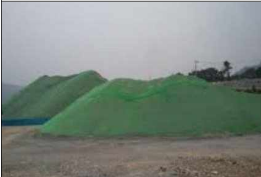
야적물 방진덮개 설치
