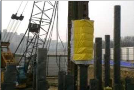
항타기 주름관 방진시설 설치
