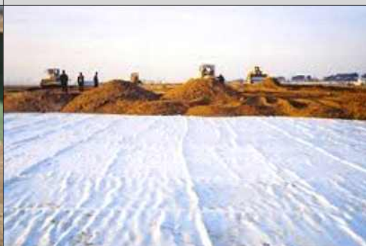
PBD공법 시행중 방진망 설치
