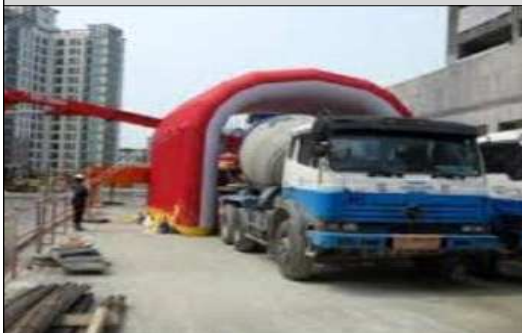
펌프카 방음커버 설치
