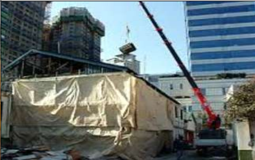
컴프레샤 방음커버 설치
