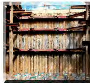
▲ 완공 후 전경
