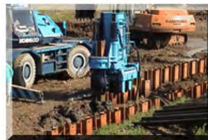
▲ Sheet Pile 항타
