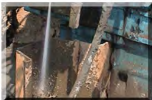
▲ Water Jet 시공
