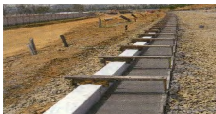
< 측구 타설 완료 후 >
