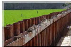
▲ 완공 후 전경
