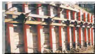
▲ Earth Anchor 공법
