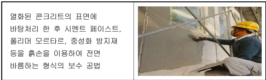
그림 3.6 Over Laying 공법
