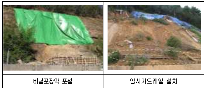
그림 3.22 비닐포장막 포설 및 임시가드레일 설치
