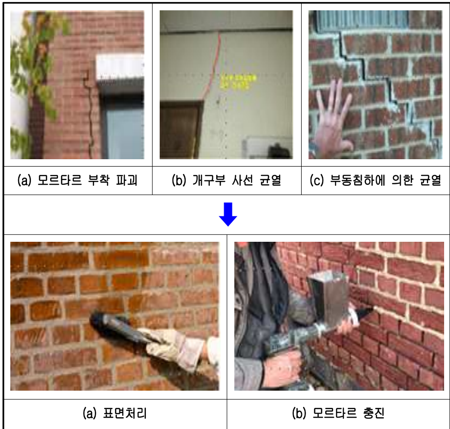
그림 3.12 벽체손상보수 공법
