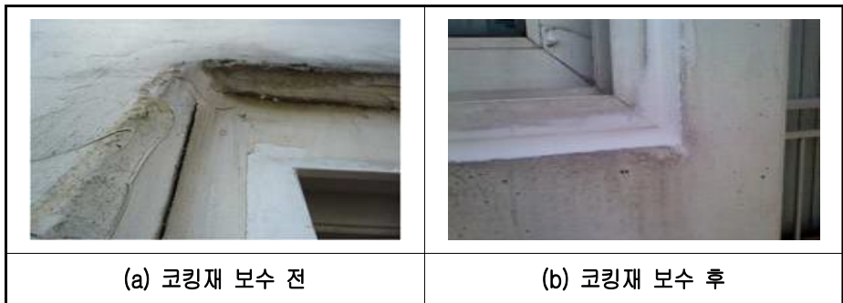
그림 3.14 창호 주위 코킹재 보수 전·후
