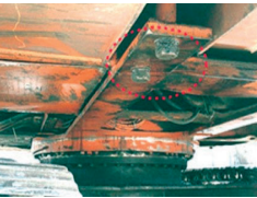
<평형추 고정볼트 설치>
