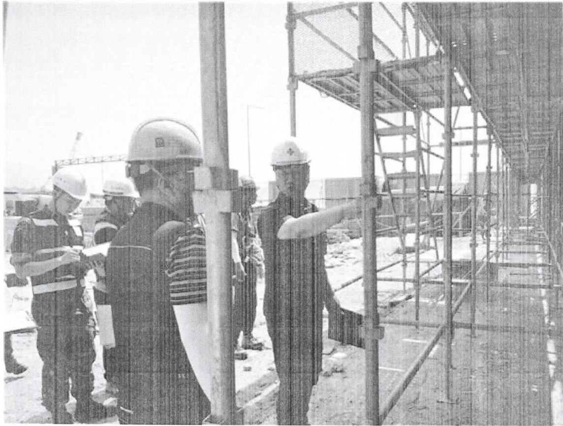
5일 실시된 안전분야 점검. 사진은 시스템 비계 설치 안정성 및 간격 등 확인하고 있다.
